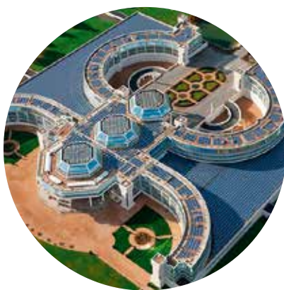
Sede social Challenger, Bouygues Construction, París
